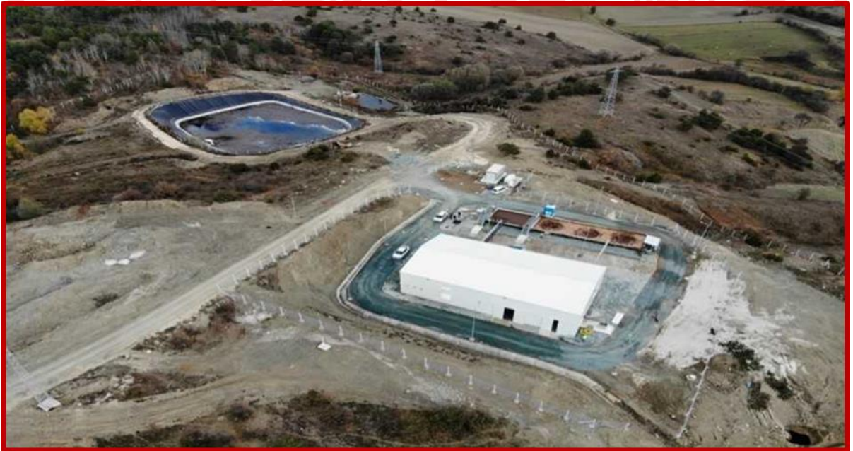
Fotoğraf-2. : Kastamonu Katı Atık Düzenli Depolama Sahasının Sızıntı Suyu Atıksu Arıtma Tesisi
