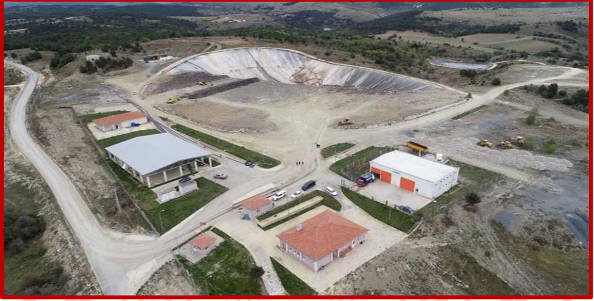
Fotoğraf-1. : Kastamonu Katı Atık Düzenli Depolama Sahasının İşletmeye Alındıktan Sonraki Hali AB hibesi ile Kastamonu Katı Atık Yönetim Projesi çalışmaları kapsamında katı atık düzenli depolama sahası sızıntı suyu arıtma tesisi ihalesi sonrası yapımı tamamlanmıştır
