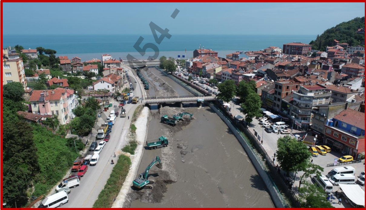
Fotoğraf 9: İnebolu İlçesinde Temizliği Yapılan Dere
