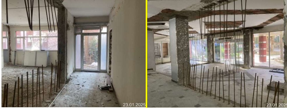
Şekil 9 Ankraj Çubuklarının Çakılması Örnek Görsel
