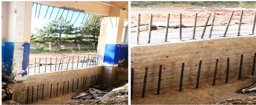
Şekil 8: ANKRAJ ÇUBUKLARININ ÇAKILMASI ÖRNEK GÖRSEL
