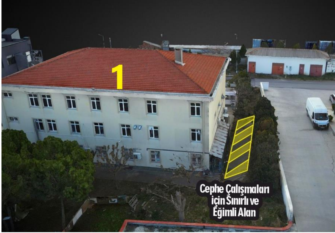
Şekil 19 : İÜCR Avcılar Kampüsü Kot Farkı Uyarısı (Düşme Riski)
