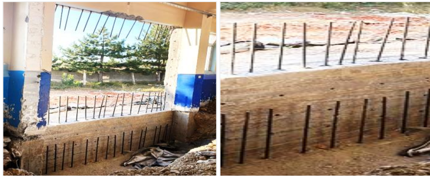
Şekil 7: ANKRAJ ÇUBUKLARININ ÇAKILMASI ÖRNEK GÖRSEL
