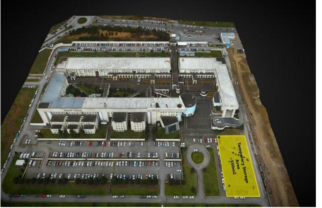
Şekil 2 Sakarya Hükümet Konağı Geçici Depolama Alanı
