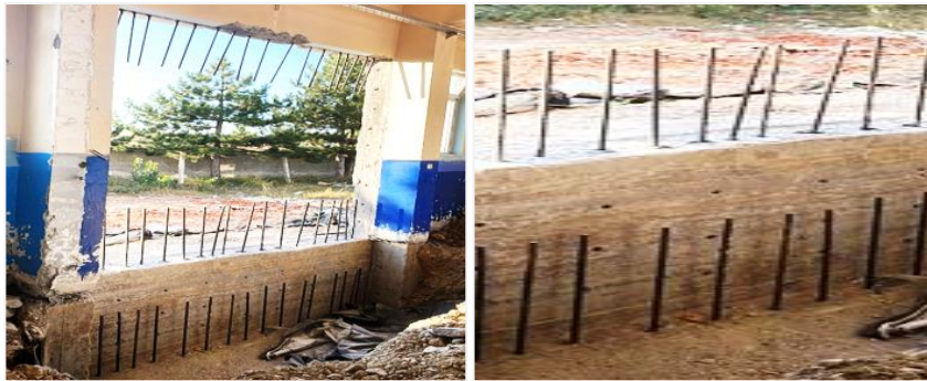
Şekil 7: ANKRAJ ÇUBUKLARININ ÇAKILMASI ÖRNEK GÖRSEL
