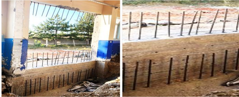
Şekil 7: ANKRAJ ÇUBUKLARININ ÇAKILMASI ÖRNEK GÖRSEL
