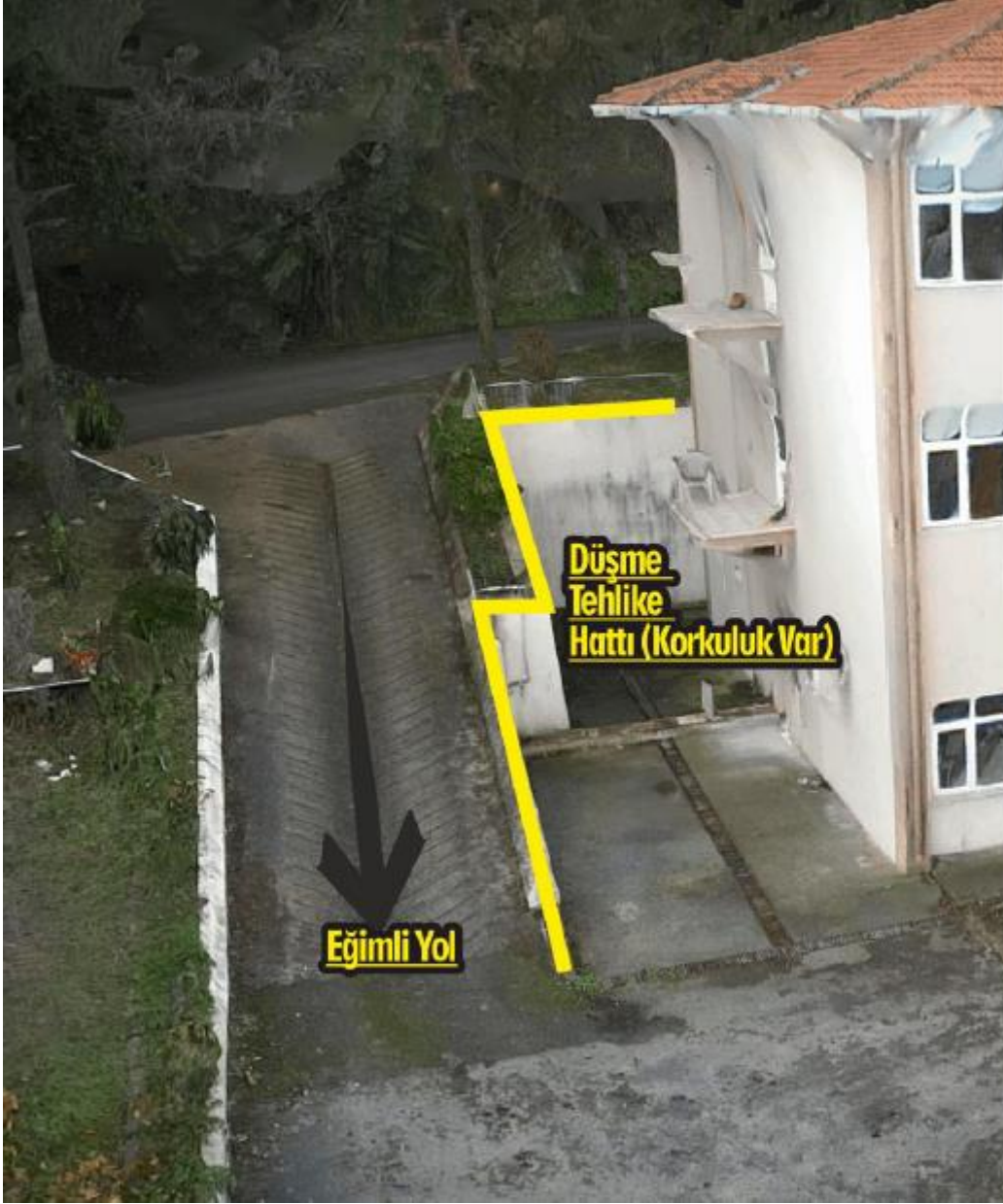
Figure 16 İstanbul Üniversitesi Kandilli Kampüsü Yeni Jeofizik Binası Riskli Alanlar
