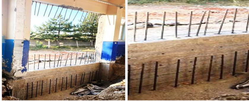
Fotoğraf 13: ANKRAJ ÇUBUKLARININ ÇAKILMASI ÖRNEK GÖRSEL
