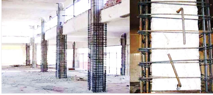
Fotoğraf 14: GÜÇLENDİRME ELEMANI DONATISININ DÖŞENMESİ ÖRNEK GÖRSEL
