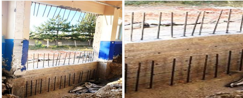
Şekil 7: ANKRAJ ÇUBUKLARININ ÇAKILMASI ÖRNEK GÖRSEL
