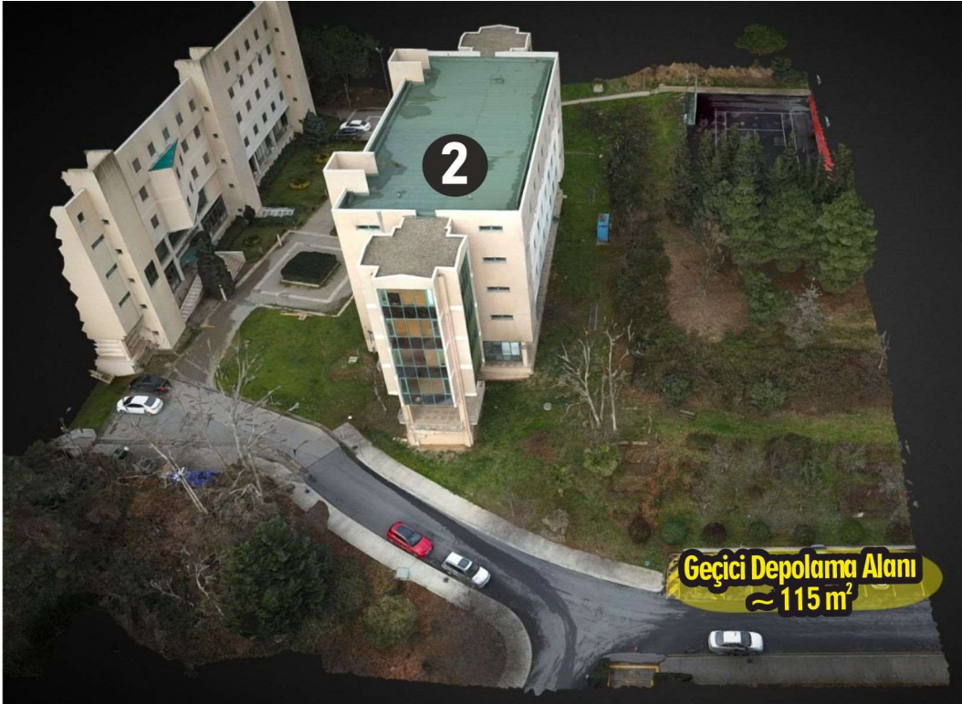
Şekil 1 İTÜ Ayazağa Yerleşkesi Ayazağa Kız Öğrenci Yurdu Binası Geçici Depolama Alanı
