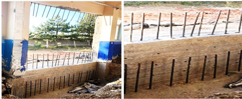
Şekil 9: ANKRAJ ÇUBUKLARININ ÇAKILMASI ÖRNEK GÖRSEL
