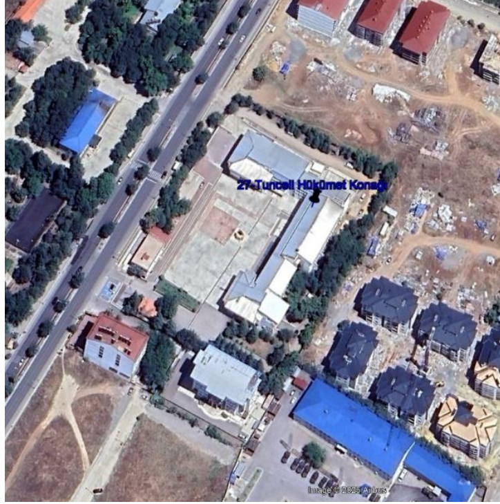
Şekil 2 Tunceli Hükümet Konağı Uydu Görüntüsü
