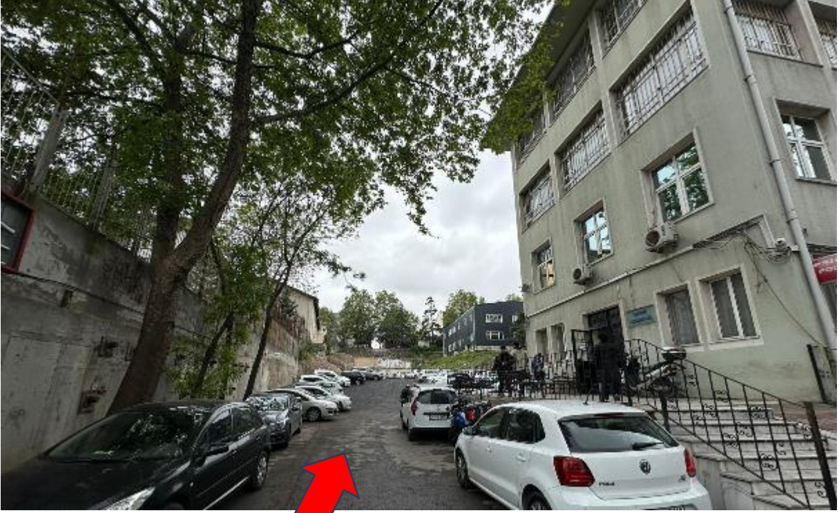
Fotoğraf 1. İstanbul Üniversitesi Tıp Fakültesi Çapa Yerleşkesi Cerrahi Hastanesi Mevcut Saha Durumu-1
