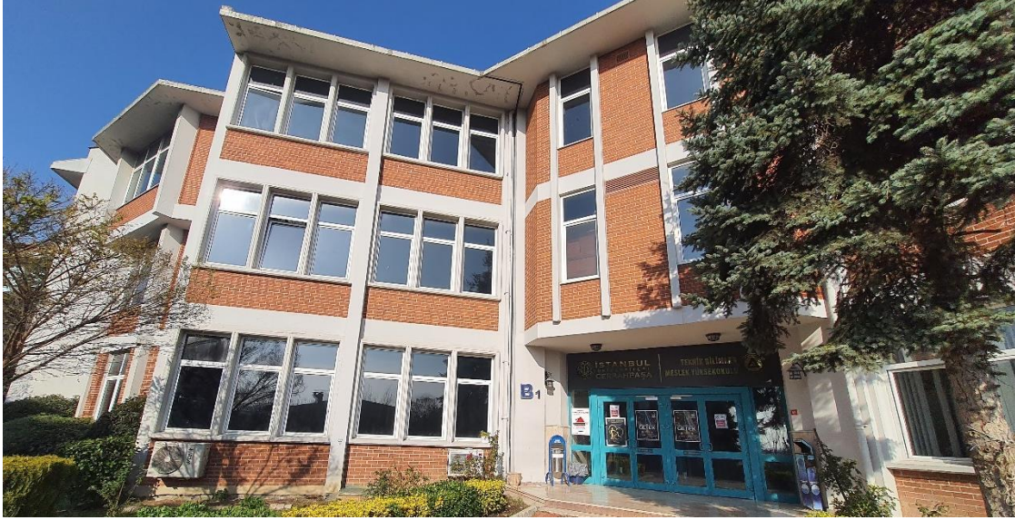
Şekil 7 B Blok HAYEF ve TBMYO
