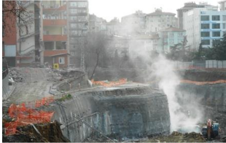
Şekil 7 Delme İşlemi Sırasında Oluşan Toz Emisyonu
