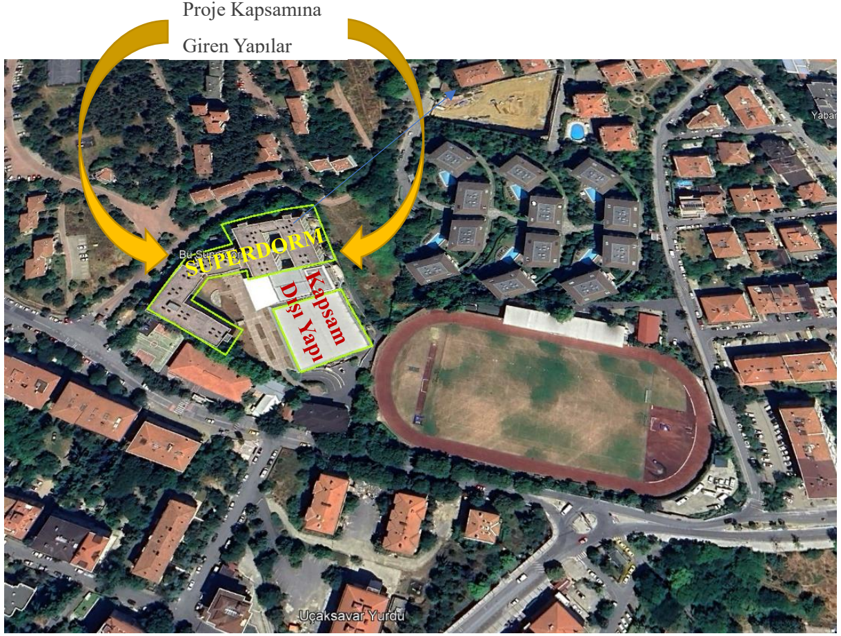
Şekil 1: Boğaziçi Üniversitesi Uçaksavar Kampüsü Proje Kapsamına Giren Yapılar
