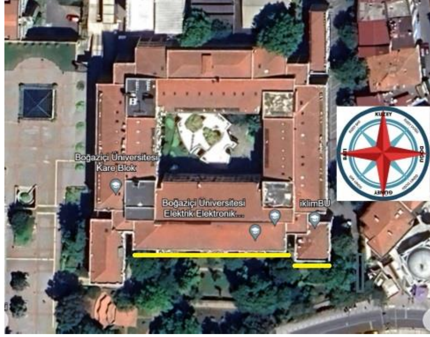
Şekil 13: Kare Blok Güney Cephe Çevresi Riskli Bitki Örtüsü
