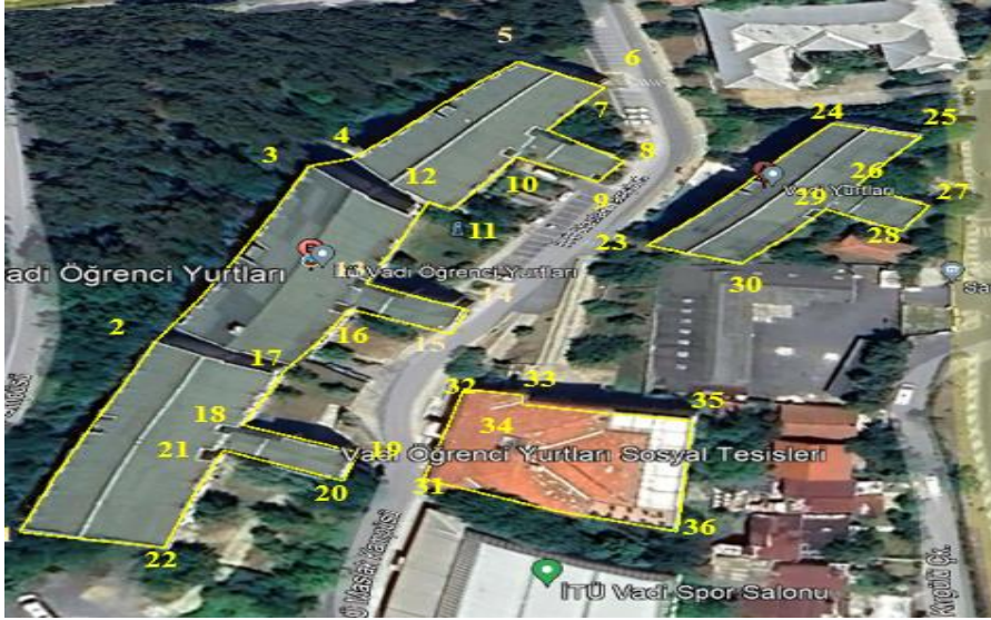
Şekil 4: İTÜ AYAZAĞA KAMPÜSÜ VADI BÖLÜMÜ PROJE KAPSAMINA GİREN YAPILARIN GÖRÜNÜMÜ
