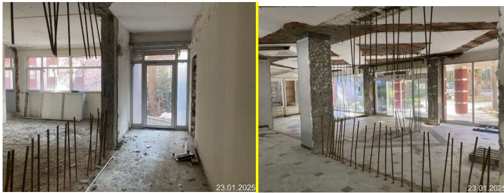
Şekil 14 Ankraj Çubuklarının Çakılması Örnek Görsel
