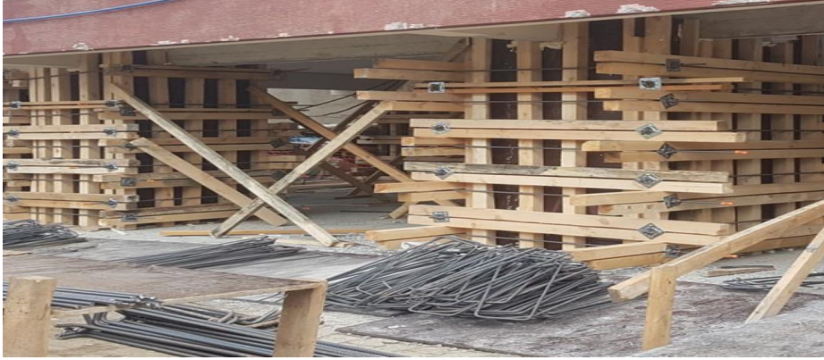
Şekil 6: ÖRNEK KOLON MANTOLAMA UYGULAMASI
