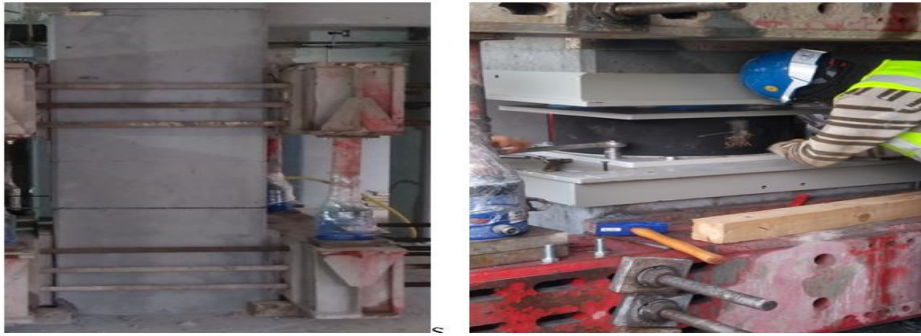
Şekil 7: ÖRNEK SİSMİK İZALATÖR YERLEŞTİRME UYGULAMASI
