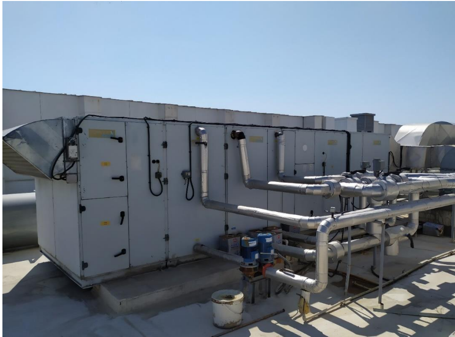
Fotoğraf 2: Hizmet Binası çatısında deęiřecek KS -5
