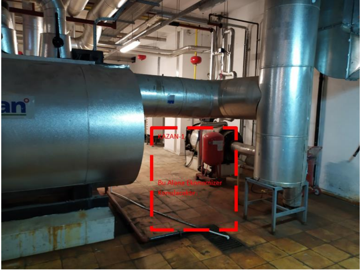
Fotoğraf 1: Kazan-1 Bacasına Yapılacak Ekonomizer Uygulaması
