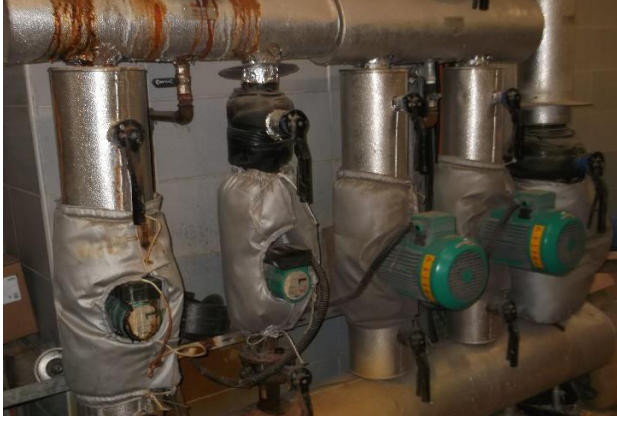
Fotoğraf 3. Isıtma - Soğutma Sirkülasyon Pompalarının Değiştirilmesi
