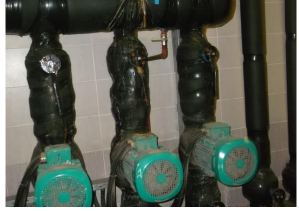
Fotoğraf 3. Isıtma - Soğutma Sirkülasyon Pompalarının Değiştirilmesi
