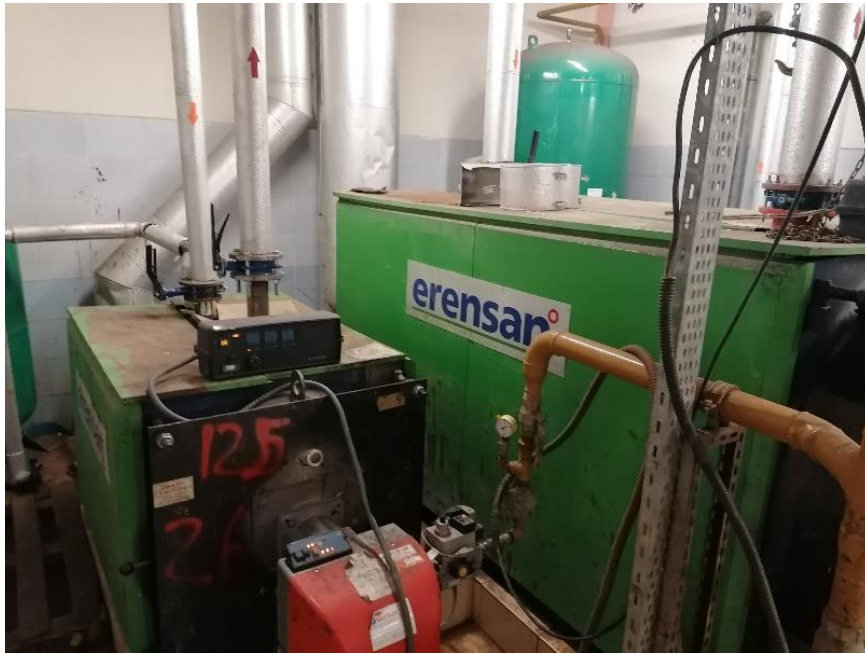
Fotoğraf 4. Sıcak Su Kazanlarının Değiştirilmesi
