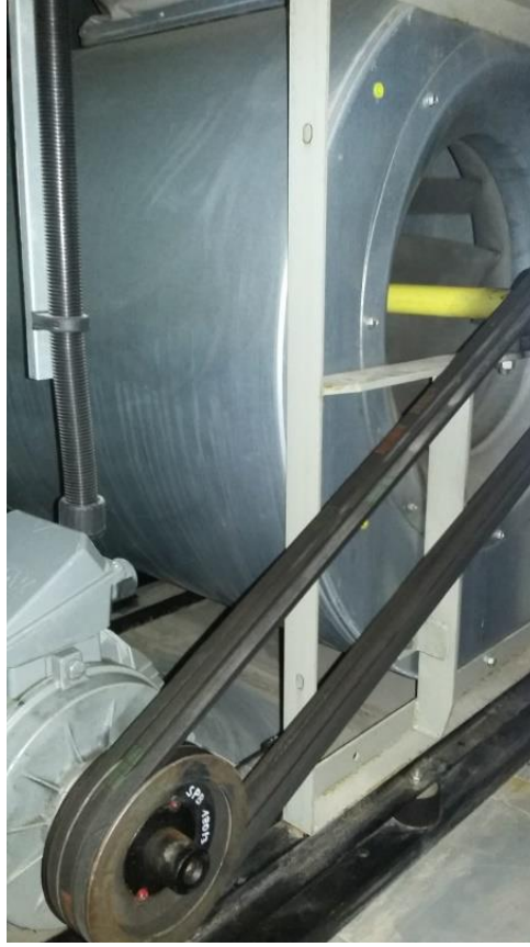
Fotoğraf 3. Fanlarda Standart Kayış Yerine Dişli Kayış Kullanılması Uygulaması
