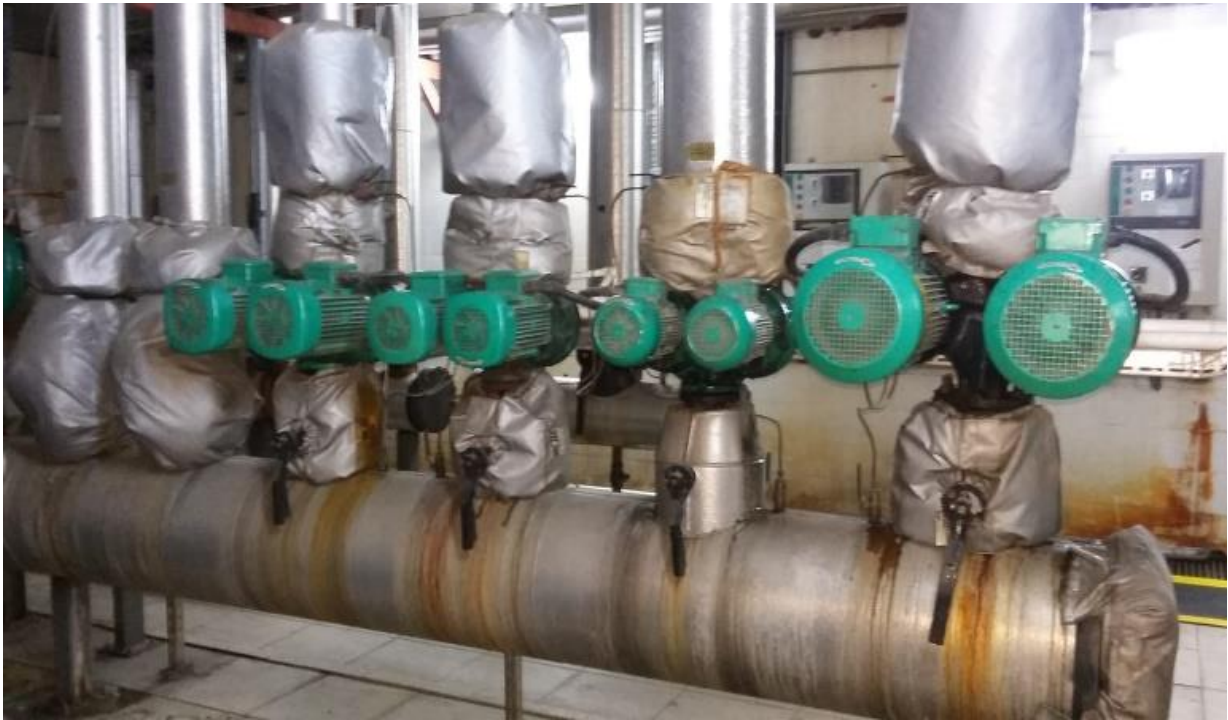
Fotoğraf 2. Soğutma Grubu Primer Devre Pompalarının Değiştirilmesi
