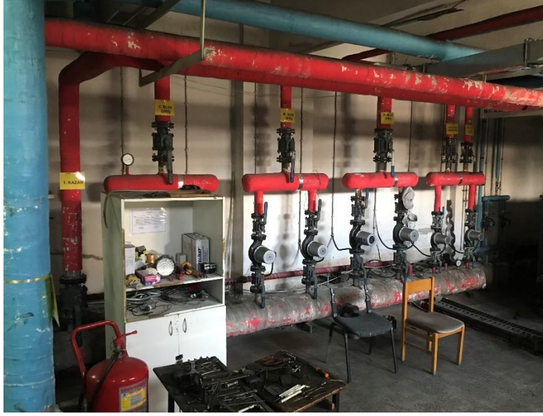
Fotoğraf 3: Değişecek Resirkülasyon Pompaları
