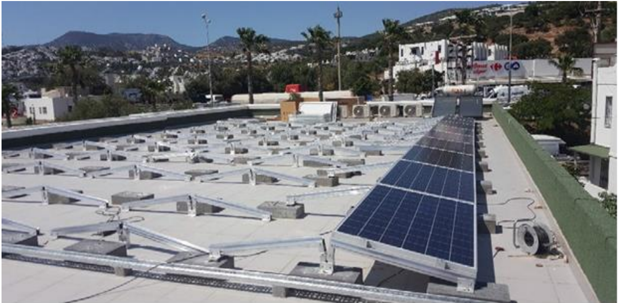
Şekil 2: Çatı tipi PV Panel Modüllerinin Temsili Gösterimi
