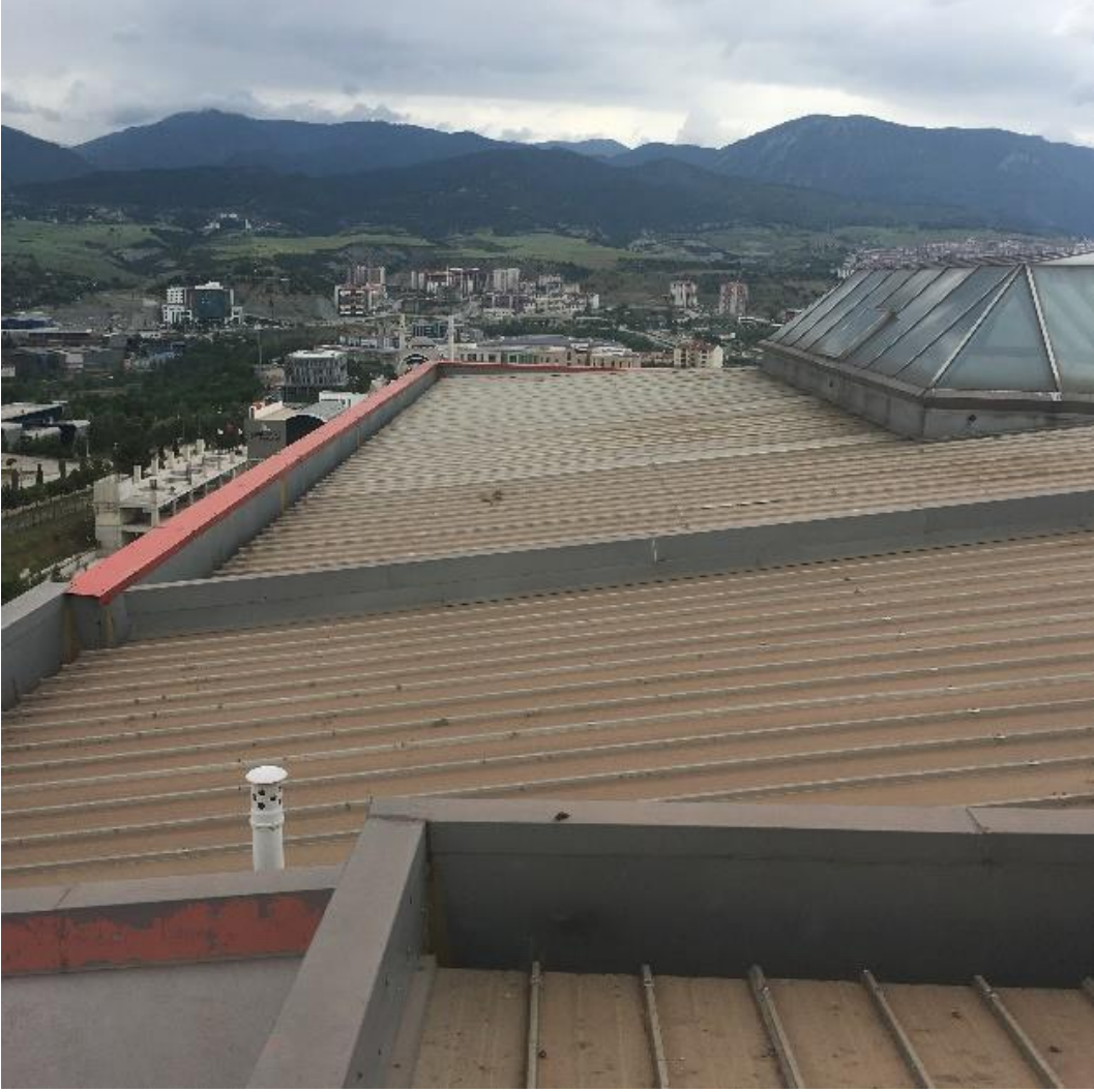
Fotoğraf 5: Fotovoltaik Panel Yerleşimi Yapılması Planlanan Mühendislik Fakültesi Çatı Fotoğrafı
