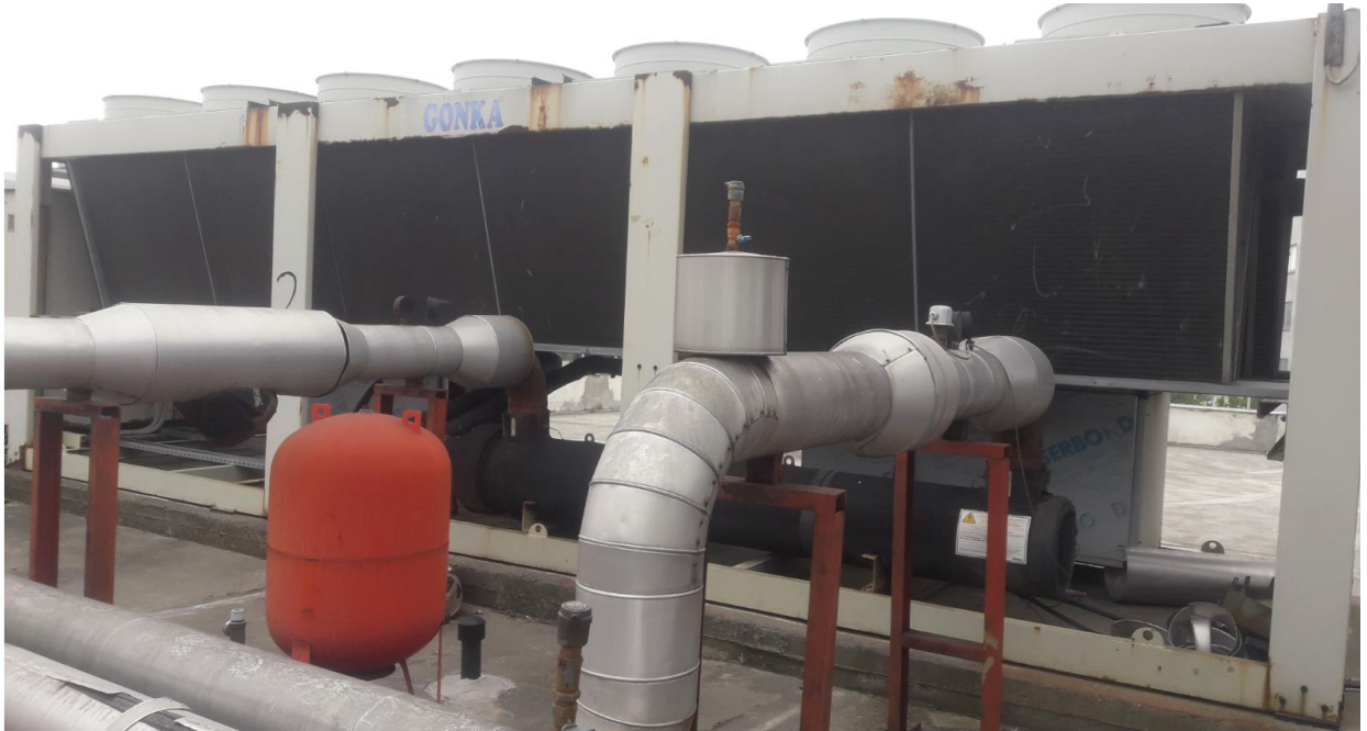
Fotoğraf 2. Soğutma Grubunun Daha Verimli Soğutma Grubu ile Değiştirilmesi
