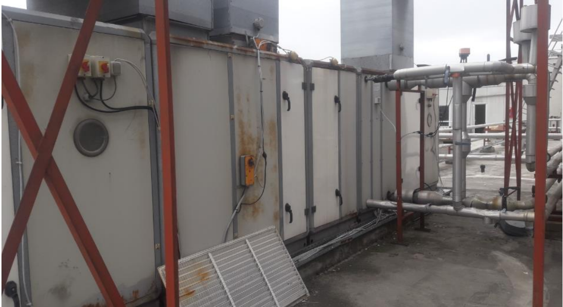
Fotoğraf 4. Mevcut Klima Santrallerinin Değiştirilmesi
