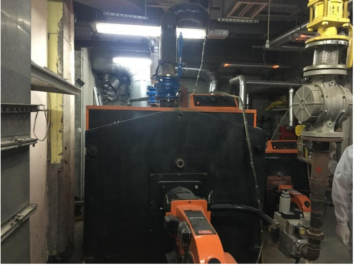
Fotoğraf 3. Sıcak Su Kazanının Değiştirilmesi
