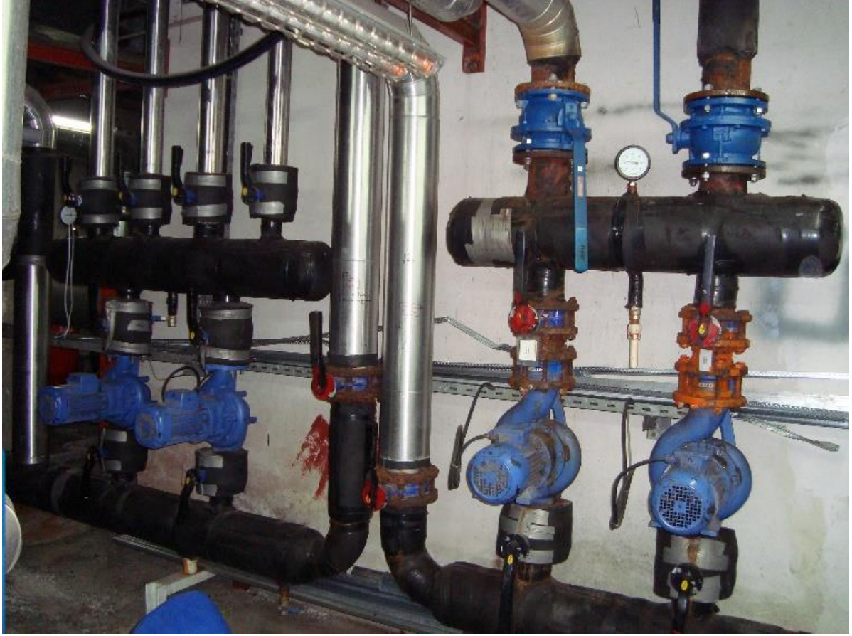
Fotoğraf 5. Isıtma – Soğutma Sirkülasyon Pompalarının Değiştirilmesi
