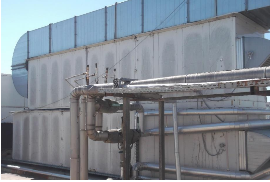
Fotoğraf 5. Mevcut Klima Santrallerinin Değiştirilmesi
