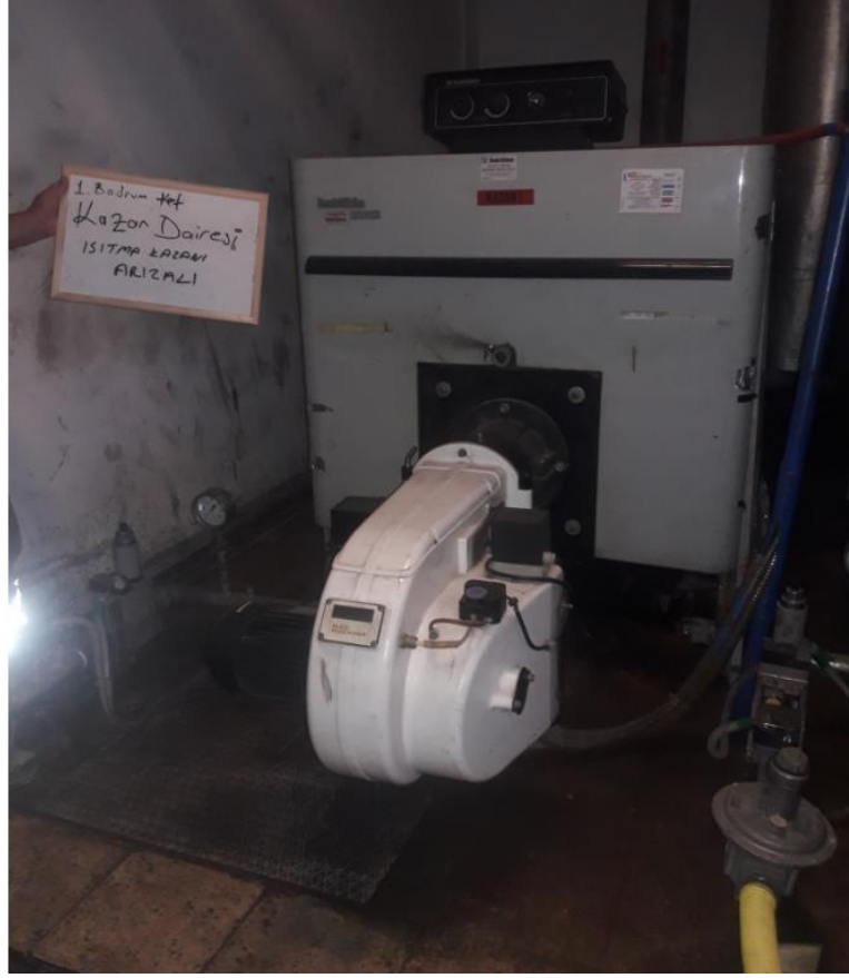
Fotoğraf 3. Sıcak Su Kazanının Değiştirilmesi
