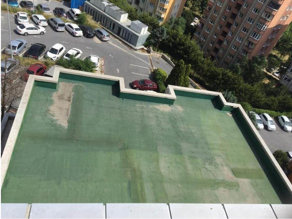
Fotoğraf 6. Fotovoltaik Panel Yerleşimi Yapılması Planlanan Başakşehir Devlet Hastanesi Çatı Fotoğrafı
