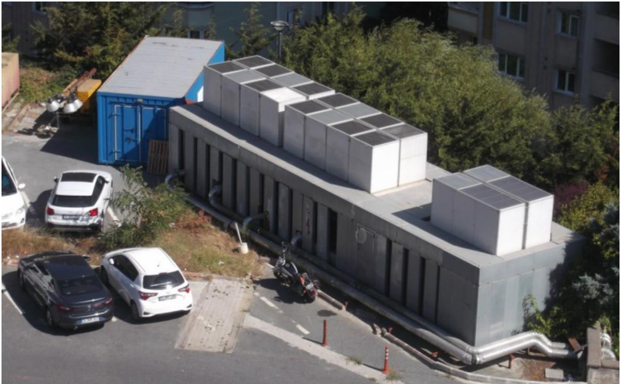
Fotoğraf 2. Soğutma Grubunun Daha Verimli Soğutma Grubu ile Değiştirilmesi
