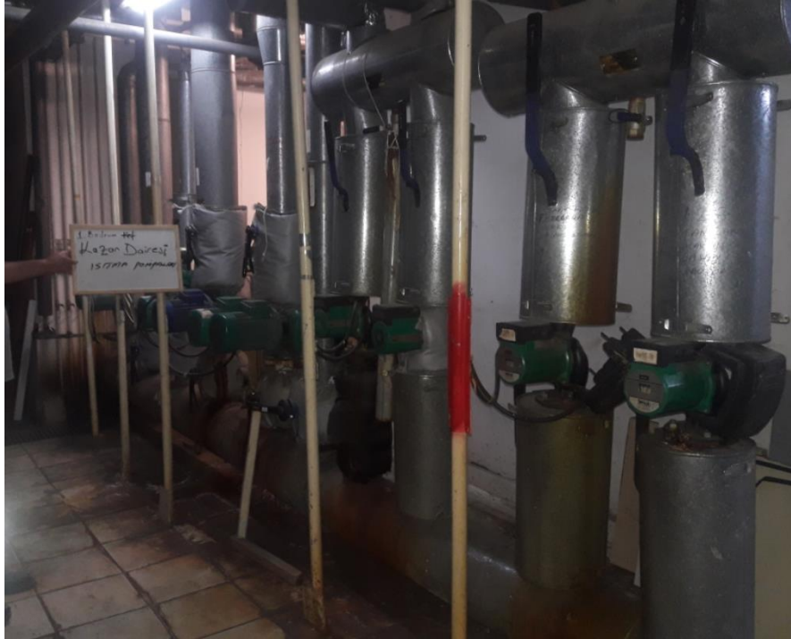
Fotoğraf 4. Isıtma - Soğutma Sirkülasyon Pompalarının Değiştirilmesi
