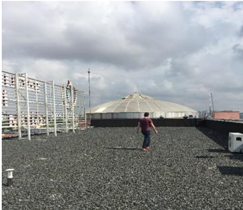
Fotoğraf 2. Bağcılar Eğitim ve Araştırma Hastanesi Uzay Çatının Fotoğrafı
