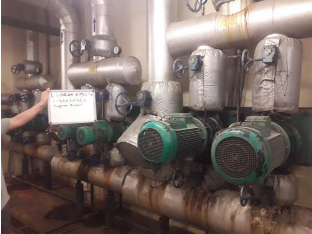
Fotoğraf 3. Isıtma – Soğutma Sirkülasyon Pompalarının Değiştirilmesi
