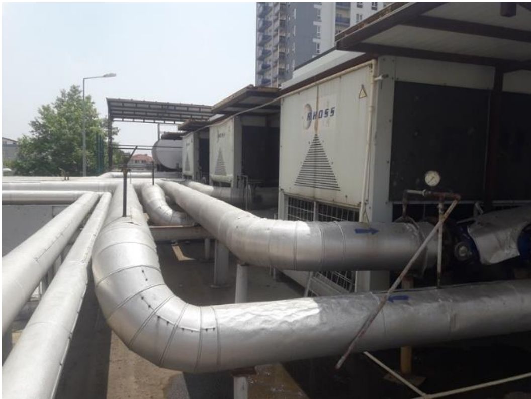
Fotoğraf 4. Soğutma Grubunun Daha Verimli Soğutma Grubu ile Değiştirilmesi
