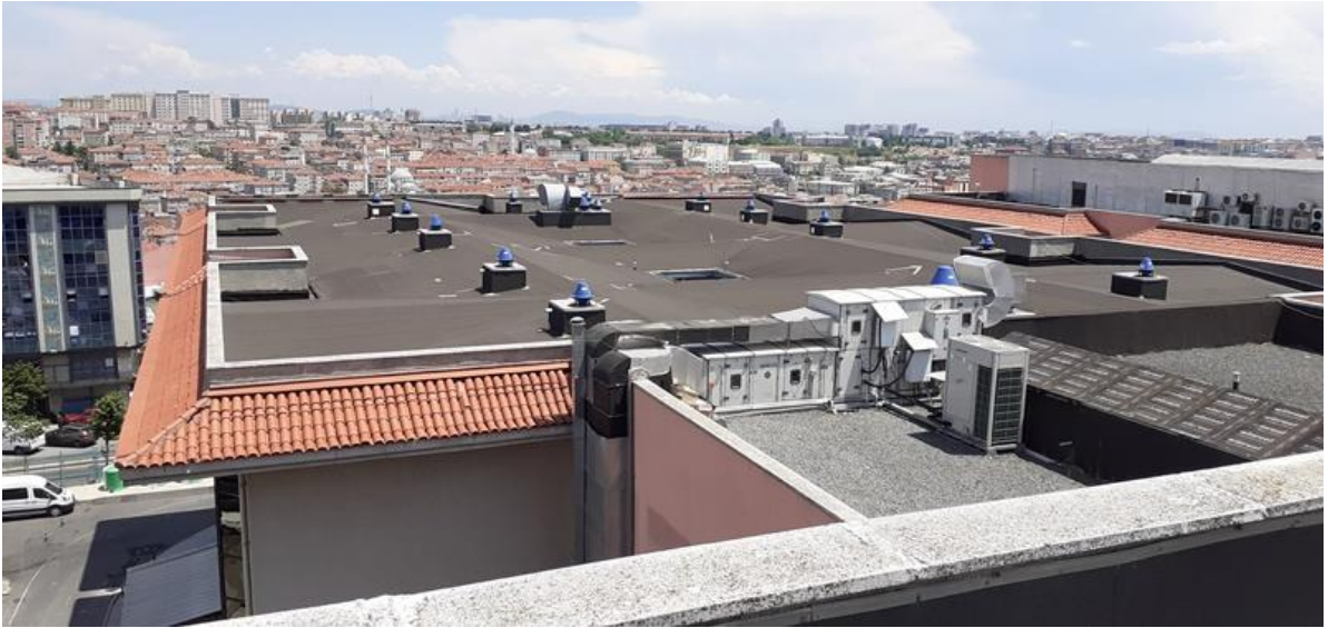
Fotoğraf 6. Fotovoltaik Panel Yerleşimi Yapılması Planlanan Bağcılar EAH Çatı Fotoğrafı
