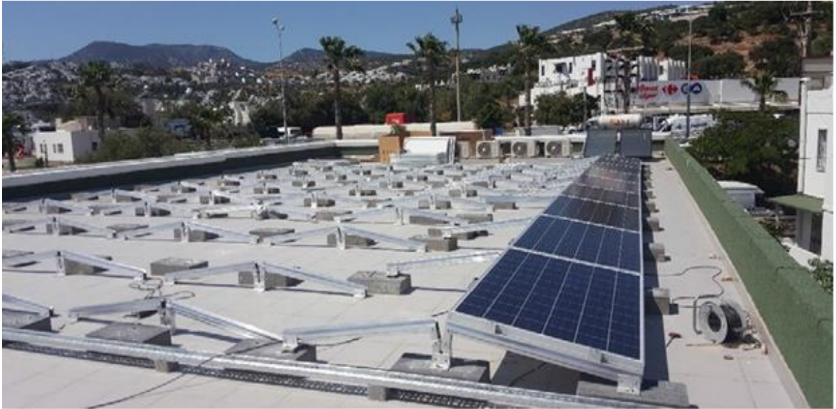
Şekil 2: Çatı tipi PV Panel Modüllerinin Temsili Gösterimi
