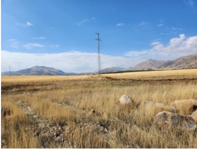
Fotoğraf 5 Parsel 1774'den geçen Yüksek Gerilim Elektrik Hattı
