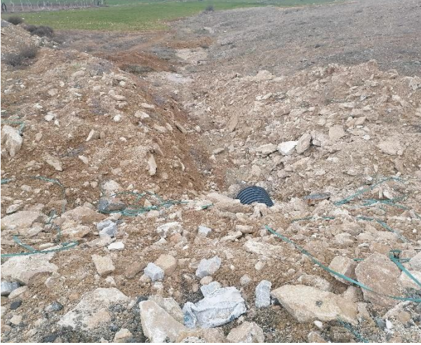
Fotoğraf 44. Alt Yapı Çalışması (Borulama)
