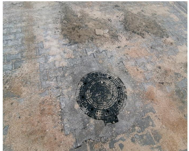
Fotoğraf 43. Toplu Konut Alanındaki Rögar (Altyapı mevcut.)
