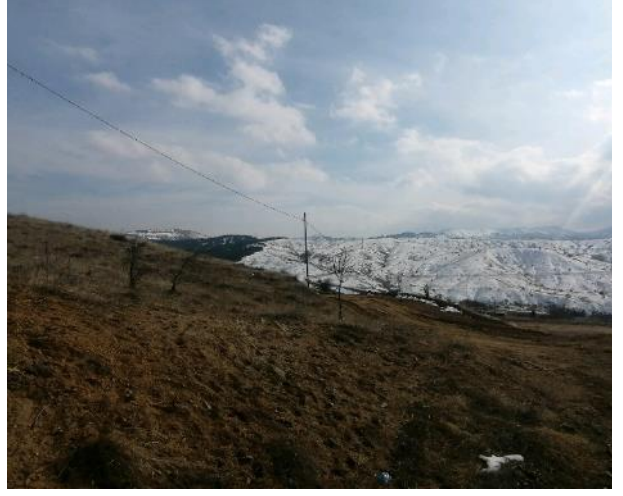
Fotoğraf 64. Parsel İçerisindeki Elektrik İletim Hatları ve Çalılar
