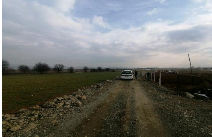
Fotoğraf 104. Parselin Yanındaki Yol/Köy Yolu
