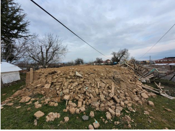
Fotoğraf 26. 177/22 Parsel Genel Görünümü (Yıkılmış Ev)
