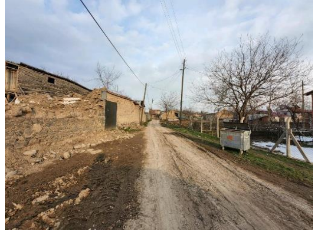
Fotoğraf 20. Parselin Yanındaki Köy Yolu
