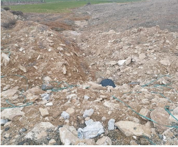
Fotoğraf 44. Alt Yapı Çalışması (Borulama)
