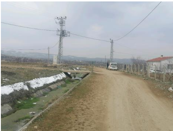
Fotoğraf 11. Köy Yolu ve Sulama Kanalı
