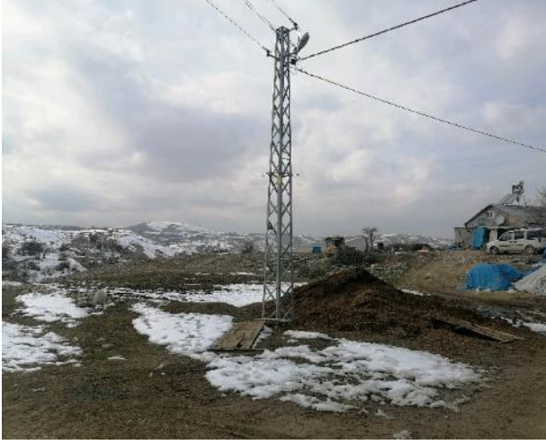
Fotoğraf 86. Parselin Yakınındaki Elektrik İletim Hattı
