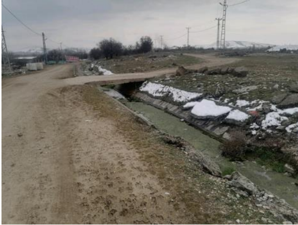
Fotoğraf 7. Parsellerin Sınırlındaki Sulama Kanalı
