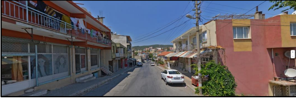
Şekil 33 : Doku Bölgesi 2: Cennetçeşme Mahallesi
