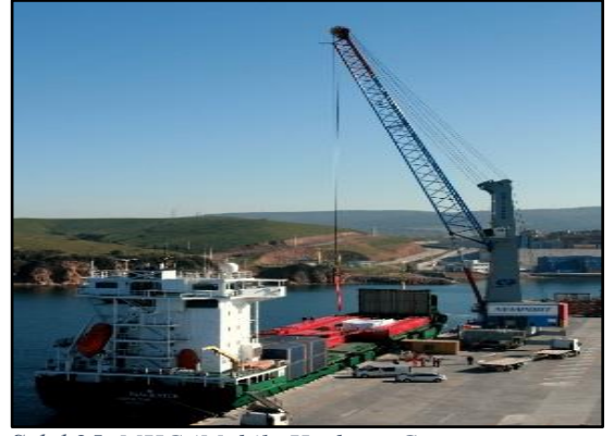
Şekil 25. MHC (Mobile Harbour Crane)
