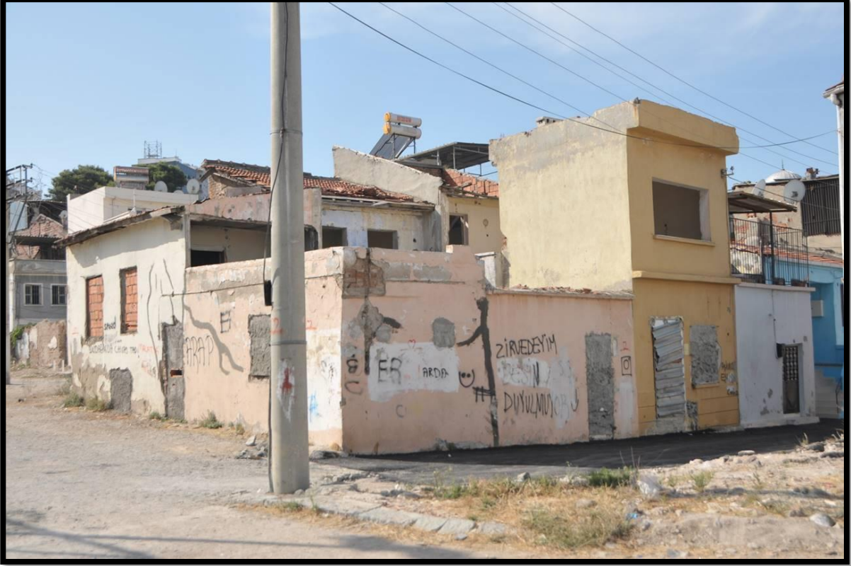
Fotoğraf 1: 105 ada 16-17-18 Parsel Tescilli Yapılar
