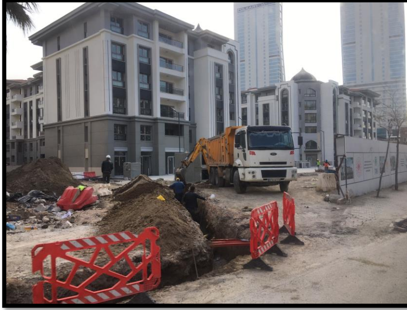
Fotoğraf 1: Trafo Alanının Mevcut Durumu
