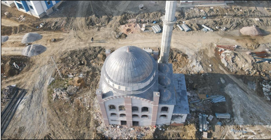
Fotoğraf 13: Cami İnşaatında Geline Süreç (2022)
