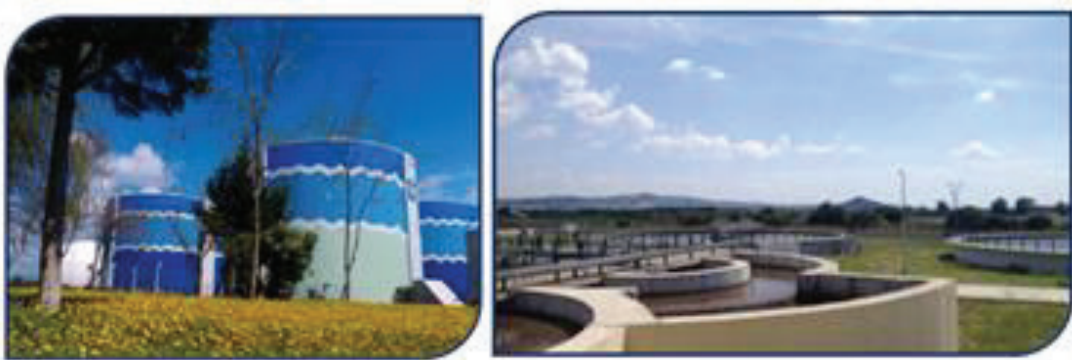
Resim 1.1. Çiğli ve Bergama Atıksu Arıtım Tesisleri (İZSU, 2021)
