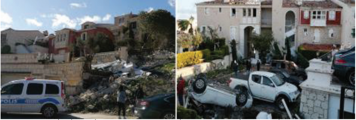
Resim 2.8. İzmir İli, Çeşme İlçesi Fırtına Afeti Hasar Fotoğrafları (İzmir Çevre, Şehircilik ve İklim Değişikliği İl Müdürlüğü, 2021)
