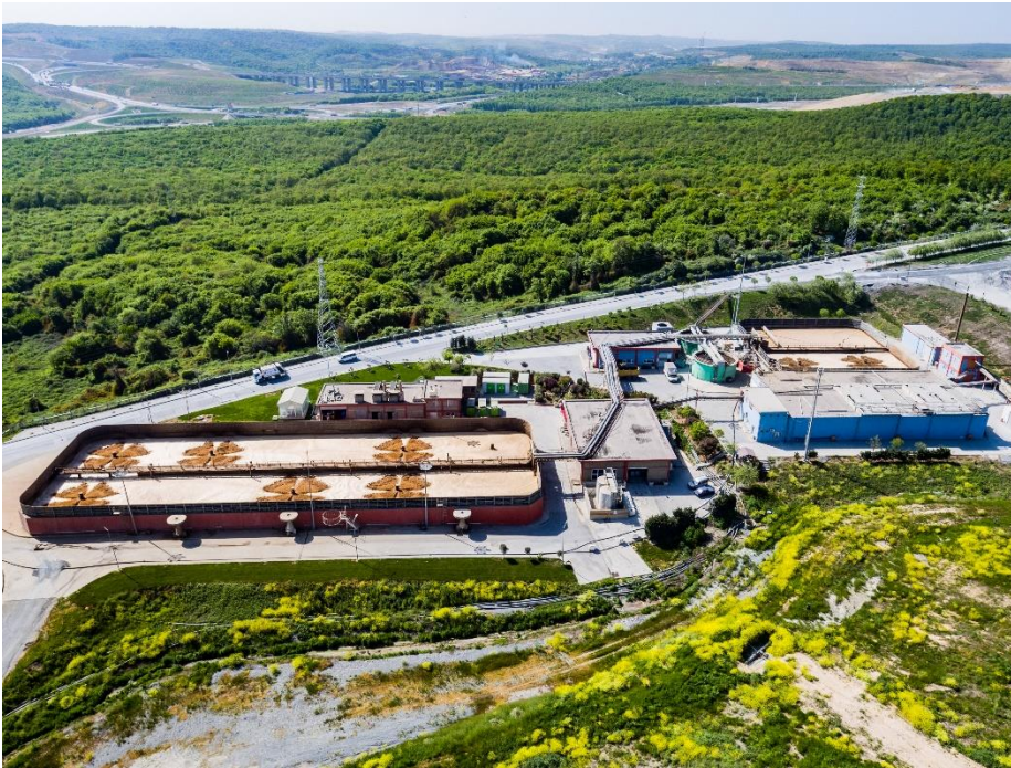
Resim 9. Çöp Sızıntı Suyu Arıtım Tesisi
