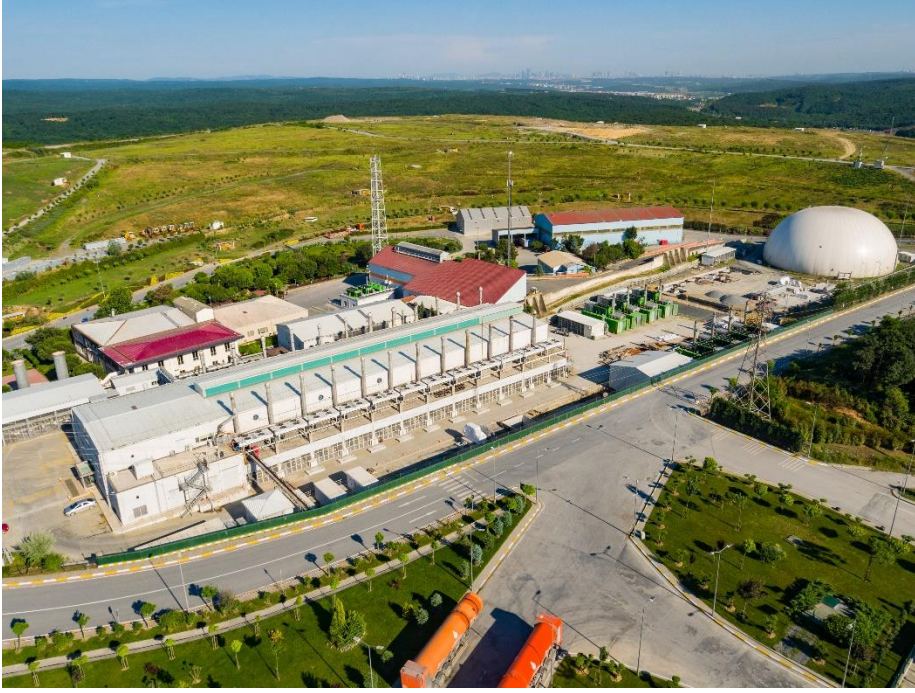
Resim 8. Çöp Gazından Enerji Üretim Tesisi
