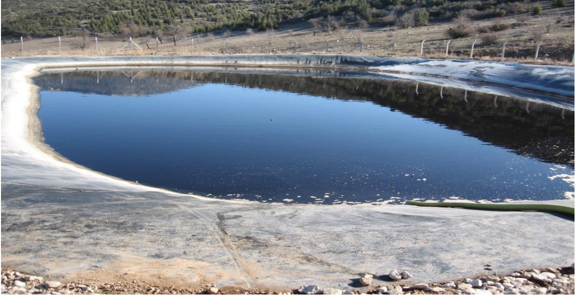
Resim B.1 – Sızıntı suyu toplama havuzu
