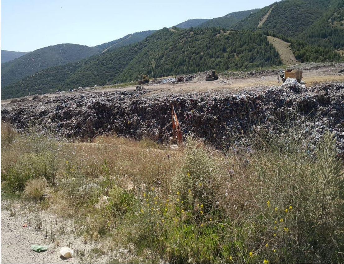
Resim C.3 – Göller Bölgesi Belediyeler Birliğine ait Koçtepe Düzenli Katı Atık Depolama Tesisi depolama alanı
