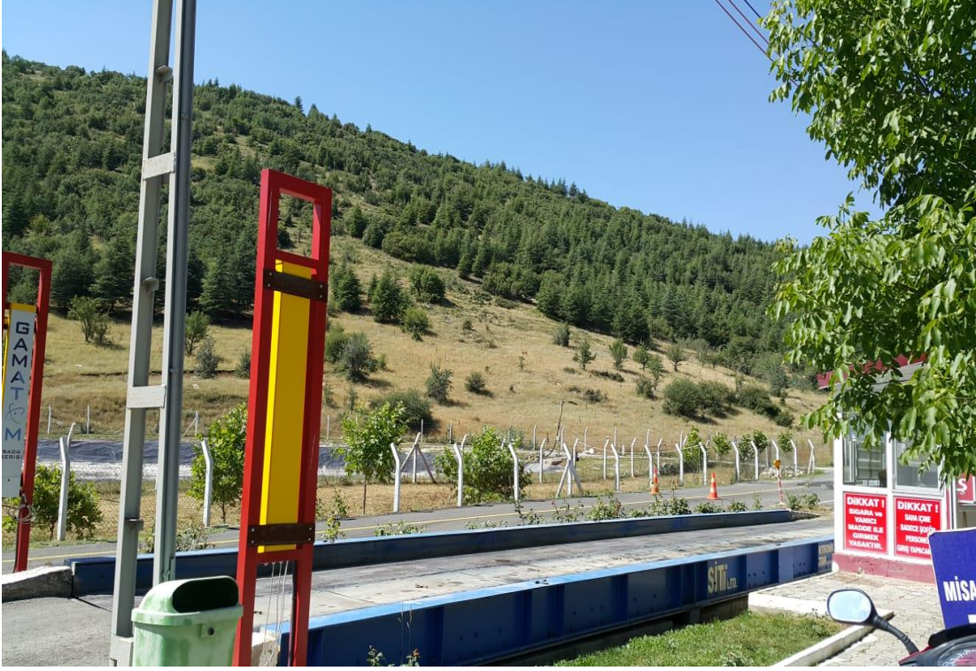
Resim C.2 – Göller Bölgesi Belediyeler Birliğine ait Koçtepe Düzenli Katı Atık Depolama Tesisi kantar ünitesi
