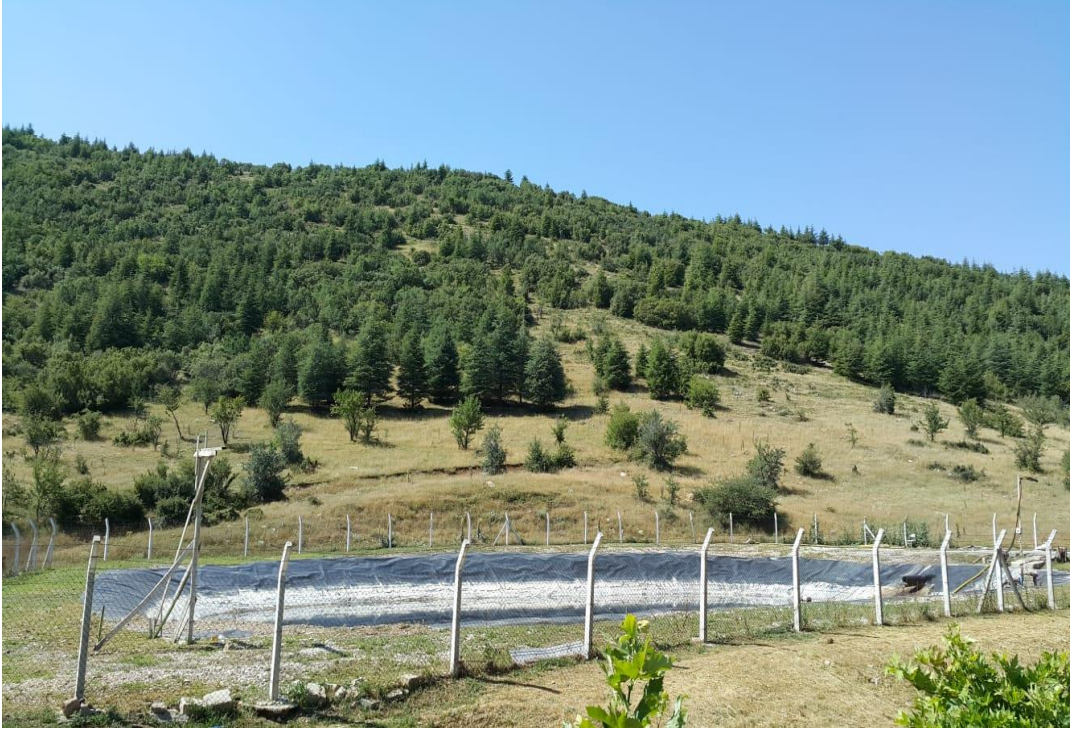
Resim C.4 – Göller Bölgesi Belediyeler Birliğine ait Koçtepe Düzenli Katı Atık Depolama Tesisi sızıntı suyu toplama havuzu
