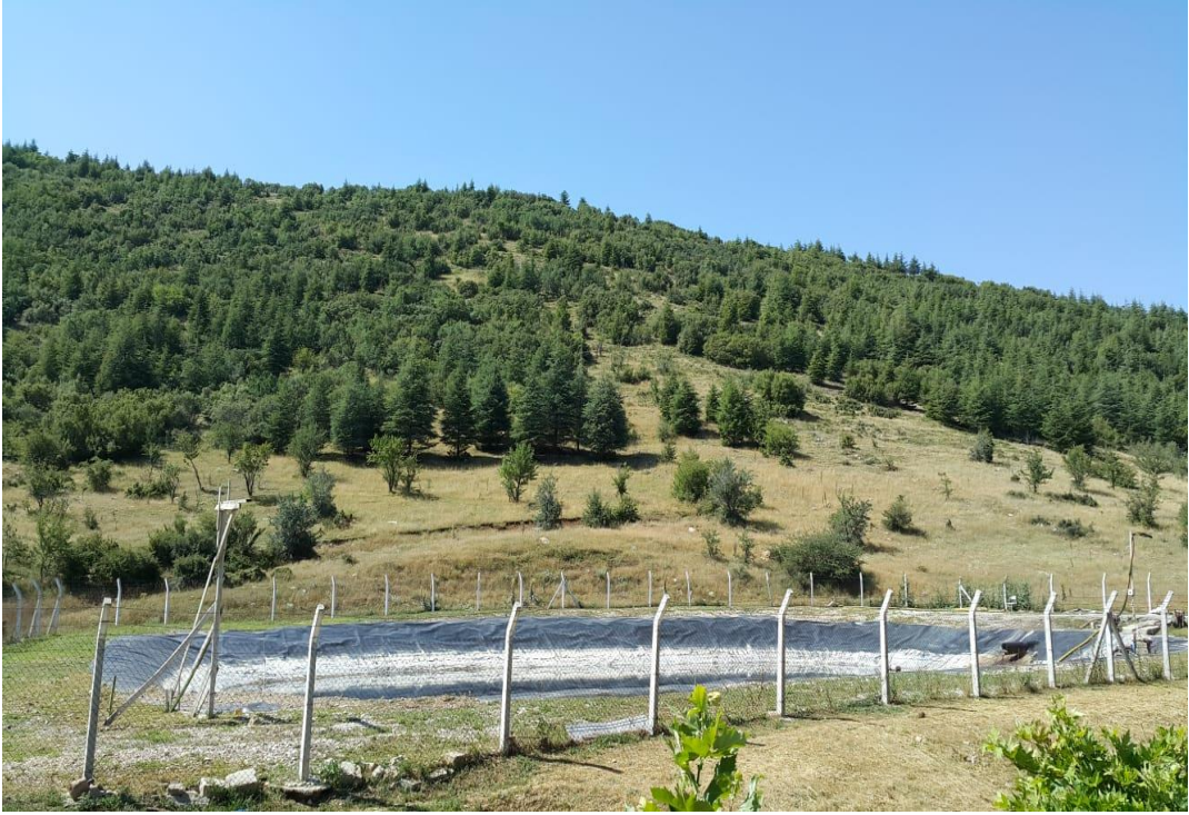
Resim C.6 – Gller Blgesi Belediyeler Birliđine ait Kotepe Dzenli Katı Atık Depolama Tesisi sızıntı suyu toplama havuzu
