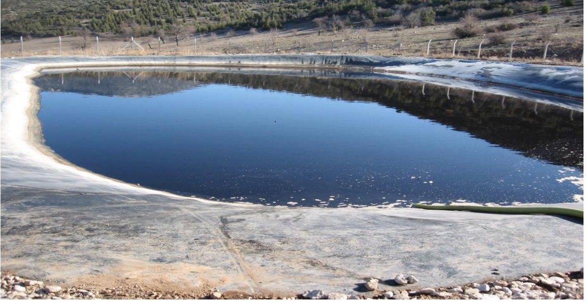
Resim B.3 – Sızıntı suyu toplama havuzu
