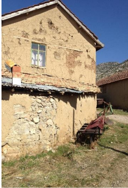
Resim6: Taş yığma yapı
