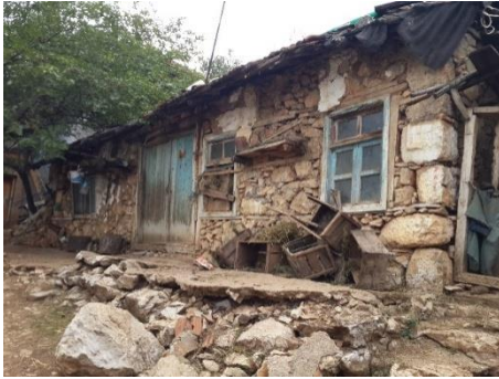
Resim8: Taş yığma yapı
