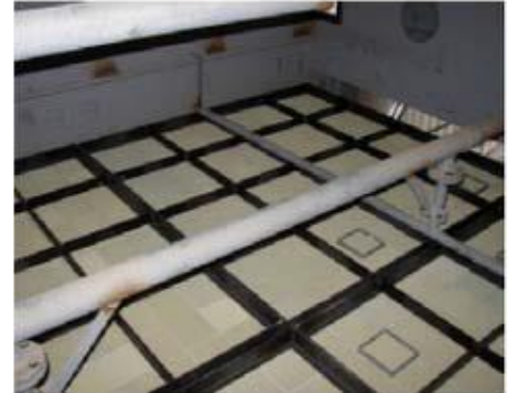
Şekil 40: SCR tekniği için kullanılan bir modül konumu örneği [140, İtalya, 2007]
