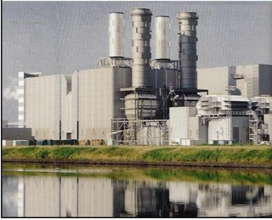
Şekil 7.8: Yakın zamanda Belçika'da inşa edilmiş gaz türbin kombine çevrim elektrik santrali
