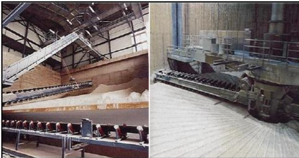
Şekil 4.23: Kapalı alçıtaşı depolama tesisleri [94, Umwelt + Technik, 2000]
