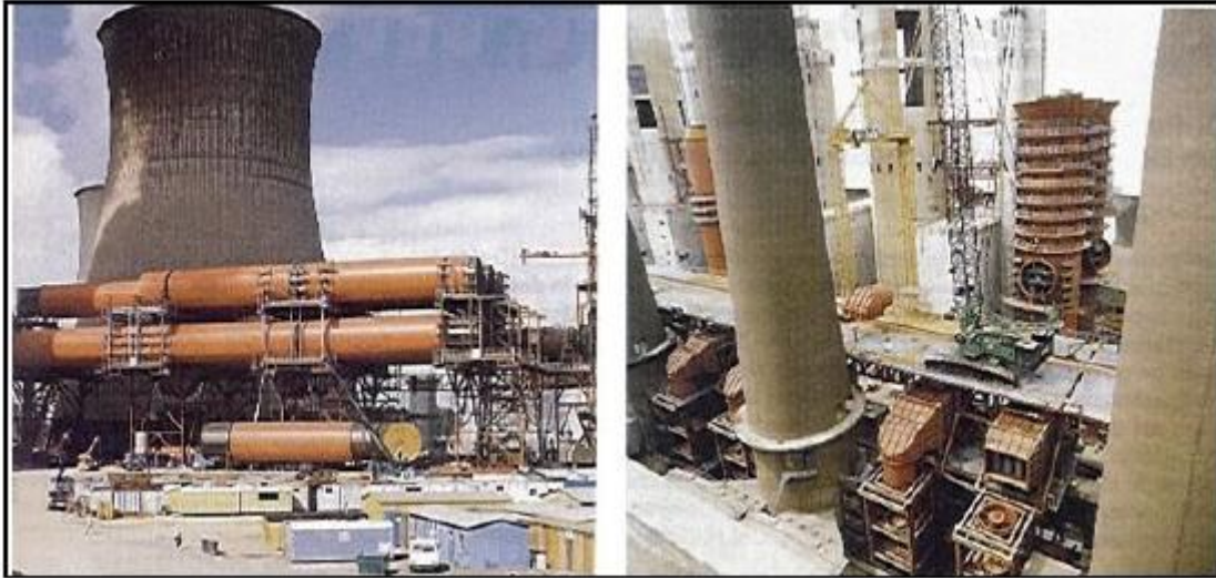
Şekil 4.18: FGD teknolojisinin mevcut bir tesise uyarlanması [94, Umwelt + Technik, 2000]
