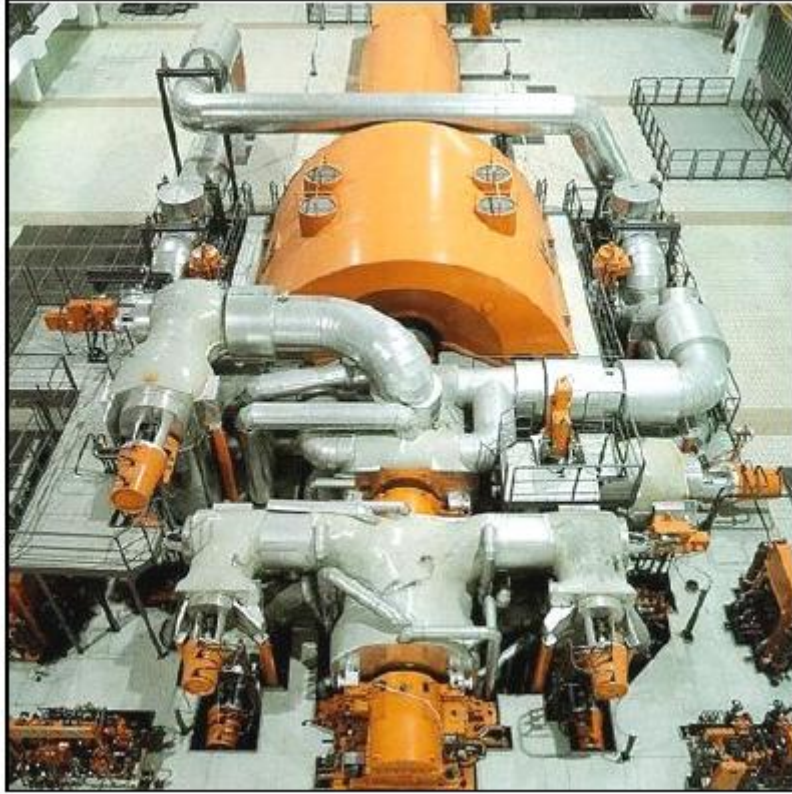
Şekil 2.1: Kömürle çalışan bir elektrik santralinin modern buhar türbini [165, NWS, 2001]
