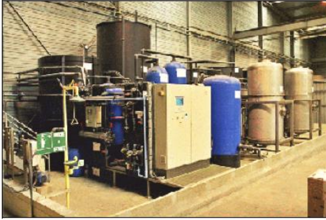
Şekil 2.43: İyon değişimini kullanarak atık su arıtma tesisi örneği (Productmetal S.A. ve Agence de l'eau Seine-Normandie)
