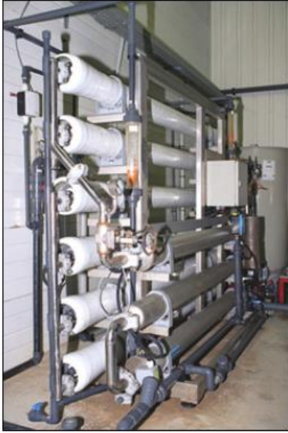
Şekil 4.19: Ters ozmoz tesisi
