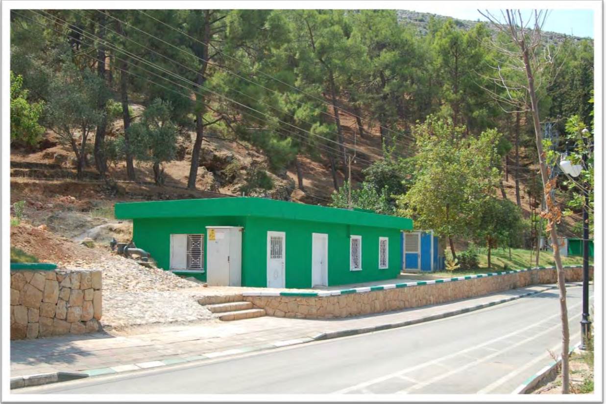
Fotoğraf-26: Su Deposu ve Trafo
