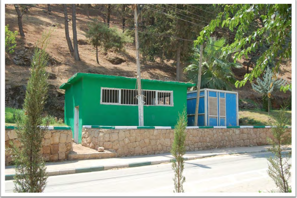
Fotoğraf-27: Su Deposu ve Trafo
