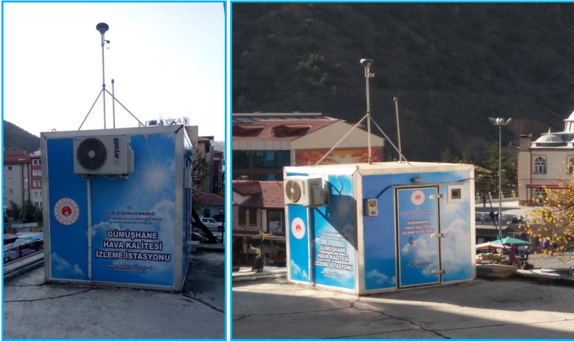
Görsel-6: Gümüşhane Hava Kalitesi İzleme İstasyonu Görüntüsü
